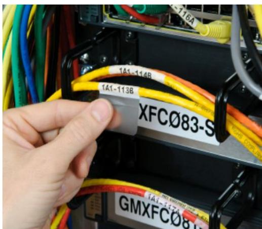
Identifique fios e cabos com estas etiquetas de vinil com parte em material transparente para autolaminação.
