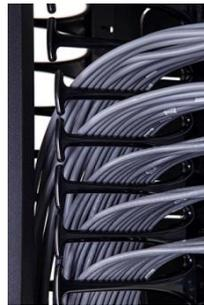
Detalhe dos fingers plásticos para passagem de cabos.
